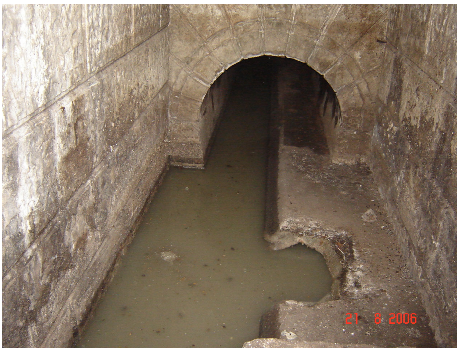
Figura 6. Visão panorâmica do túnel de esgoto na Av. Junqueira Ayres.
