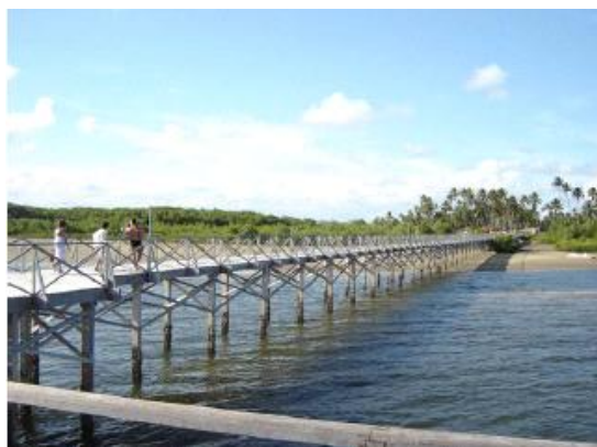
Figura 96. Gaudalupe. Pier sobre o rio Formoso construído com recursos do PRODETUR I
